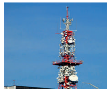
Wieża na dachu z charakterystycznymi antenami linii radiowych
